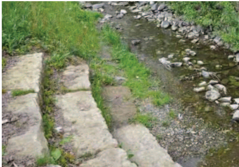
Natursteinstufen am Gewässerrand - Foto: Th. Paulus
