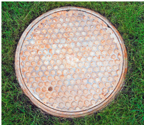
Oft liegt der private Kontrollschacht im Vorgarten zwischen Gebäude und Straße
