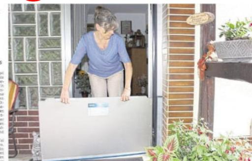
Hüllspalt auch ein Seebach zeigt bei der Montage, wie sie sich bei Falle eines Hochwassers oder Starkregenereignisses gegen eindringendes Wasser schützt. Die Element aus Aluminium lässt sich schnell und unkompliziert vor der Fassade montieren.
