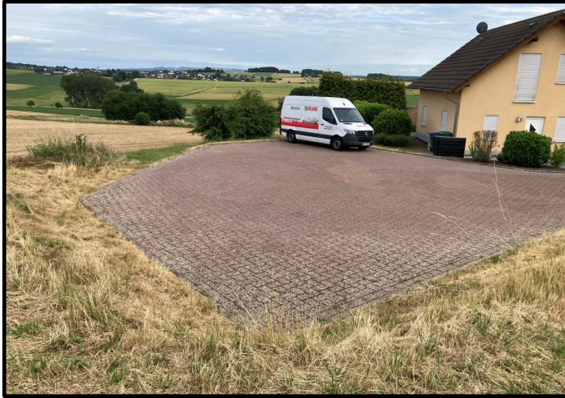
Blick auf den Wende- hammer im Westen von Norden
