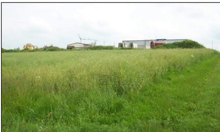
Abb. 12: Blick nach Süden aus dem geplanten Gewerbegebiet auf die vorhandene gewerbliche Bebauung
